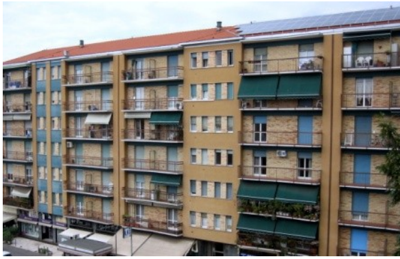
Uno degli stabili del complesso realizzato negli anni '60 a Milano - Facciata su Via Feltre
